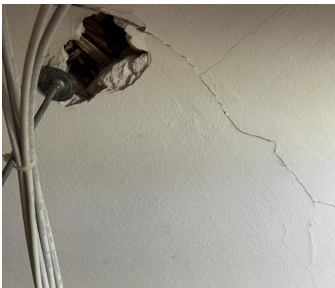
S1 : Fissure en faux-plafond «salle documentation»
