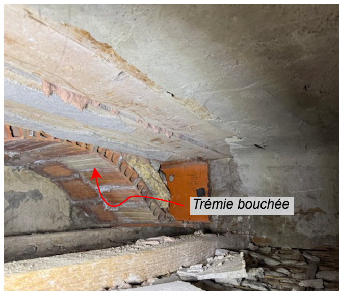
S1 : Ancienne trémie bouchée contre façade Est
