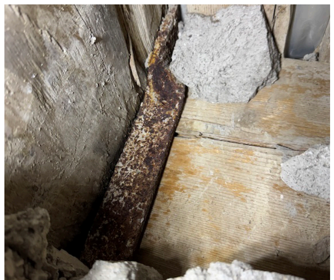
S4 : Assemblage des poutres par étrier
