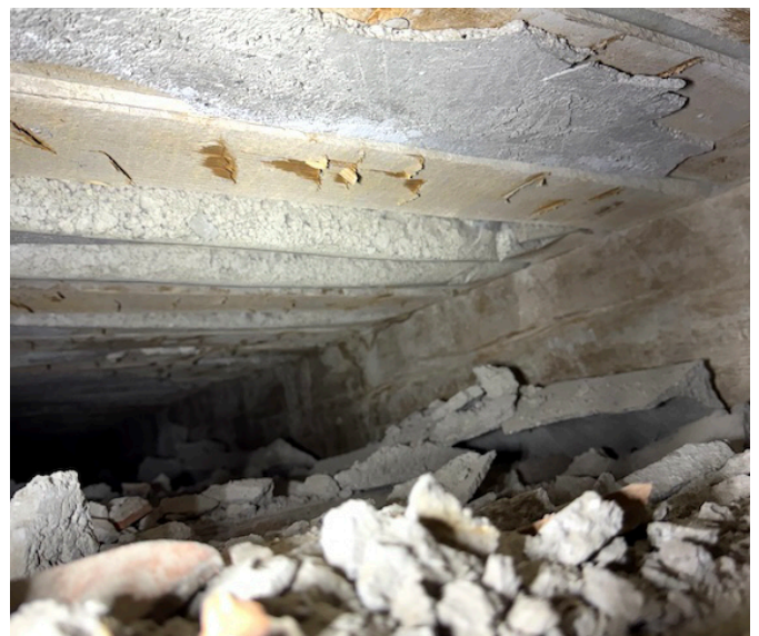
S4 : vide entre poutres avec gravats
