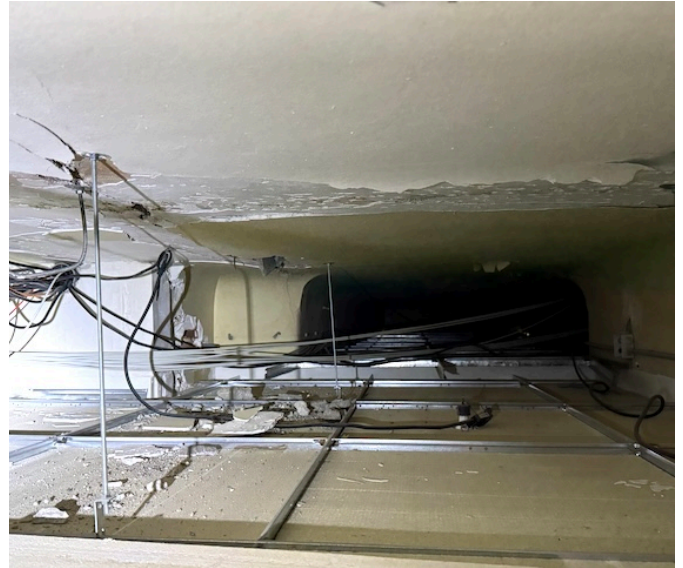
S3 : chute de matériaux sur faux-plafond acoustique
