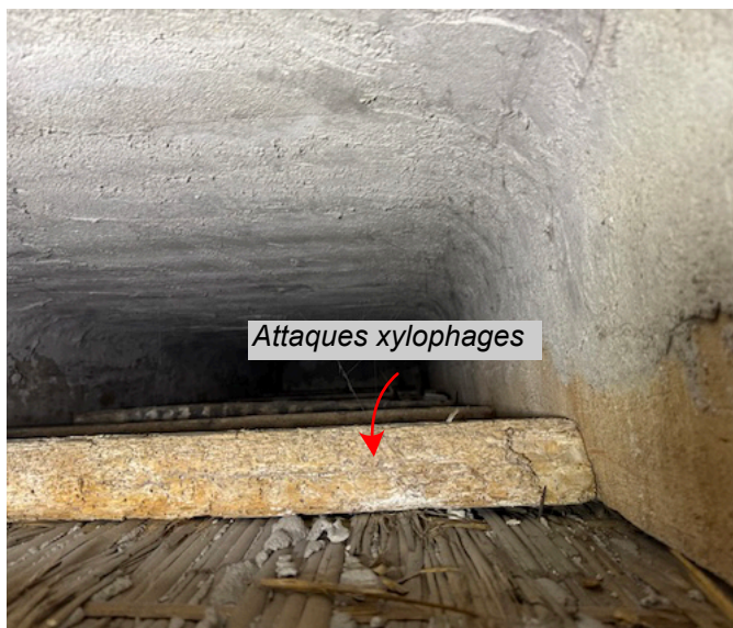
S1 : Sondage sur la travée Est-Ouest entre poutres
